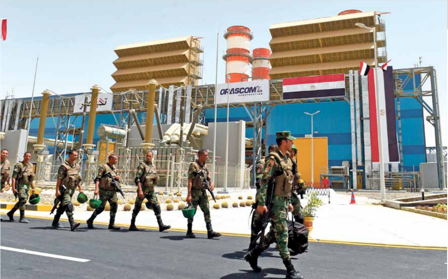
جنود مصريون أمام محطة كهرباء، غرب سيناء، في 24 نوفمبر 2018 (أحد تصوير)، مراسل فرنس
